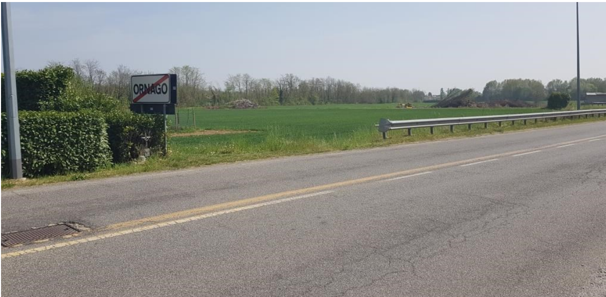
Ultimo tratto di realizzazione della nuova pista in Comune di Ornago
